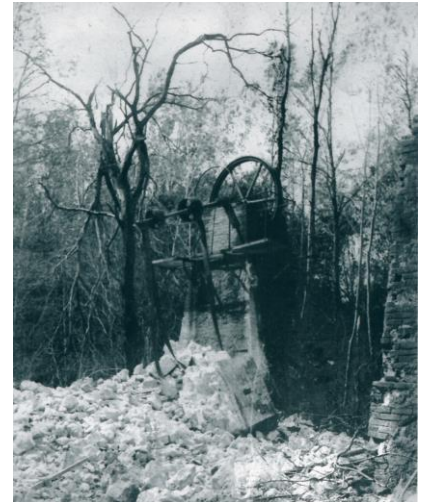
Resti del polverificio dopo l'esplosione avvenuta il 31 maggio 1916, causata dal surriscaldamento della polvere nera.
