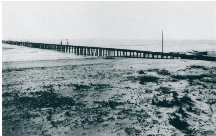
Il pontile della S.I.P.E. costruito nel 1913. Era lungo 276 metri e veniva utilizzato dall'azienda per spedire i materiali verso i propri stabilimenti e verso la Sardegna, la Corsica e la Costa Azzurra. Per incuria il pontile cadde in rovina negli anni Trenta.
